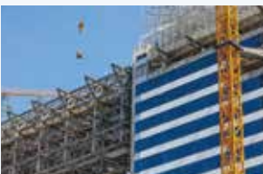
工程施工放样
